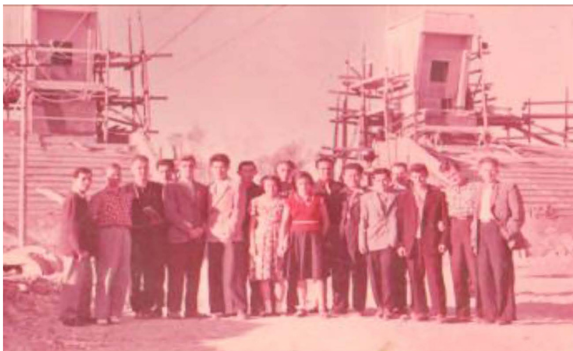
Рисунок 1 – Делегация Казахстана на строящемся стадионе
