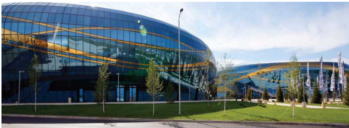
Рисунок 5 – Современный универсальный спортивный комплекс, построенный к Универсиаде 2017 г., вид снаружи
