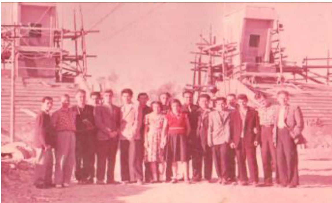
Рисунок 1 – Делегация Казахстана на строящемся стадионе
